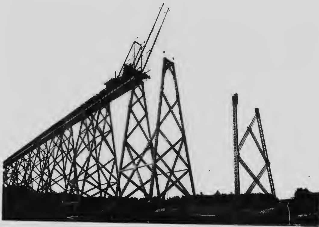
CAP ROUGE VIADUCT
