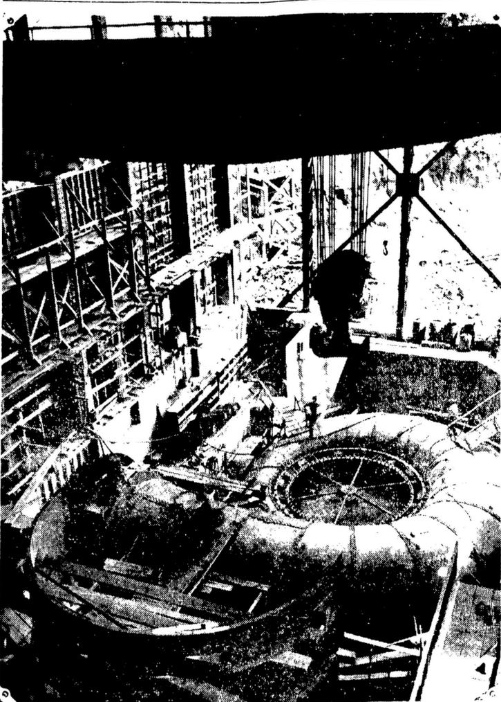
圖為秘詩七火公司。在拉斯建埠附近。建築龐大四萬七千匹馬力打電渦輪機。經於十四個月前開始建築。將於十月間完成。建築費式百五十拾萬元。
