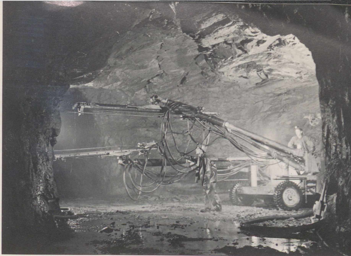
Forage dans une mine d'Elliot-Lake.
