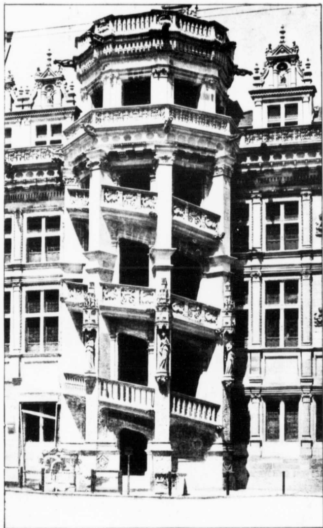
FIG. 43.—Escalier à Jour, Château de Blois, Touraine ; showing arrangement of the external balustrades
