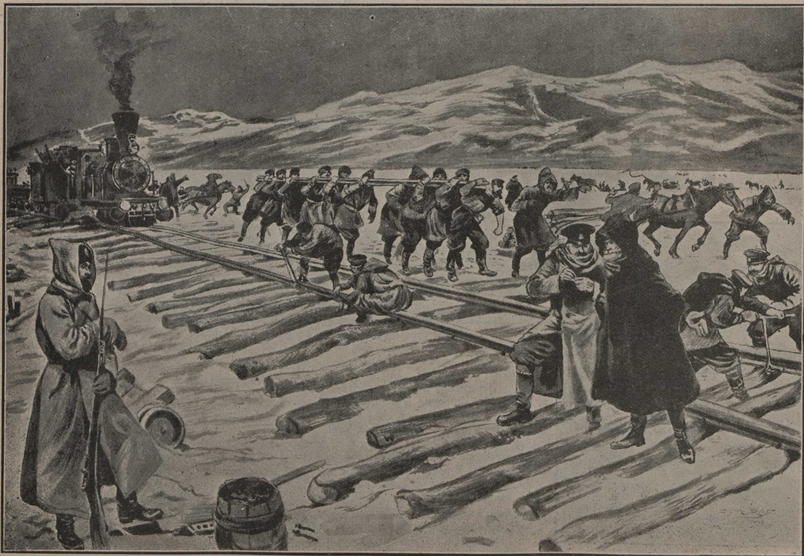
LA TRAVERSÉE DU LAC BAIKAL — Construction de la voie ferrée sur la glace : la pose des rails
