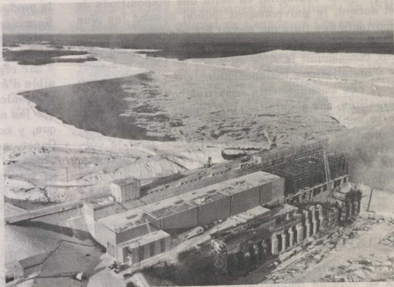
Le barrage de Kettle Rapids en construction.
