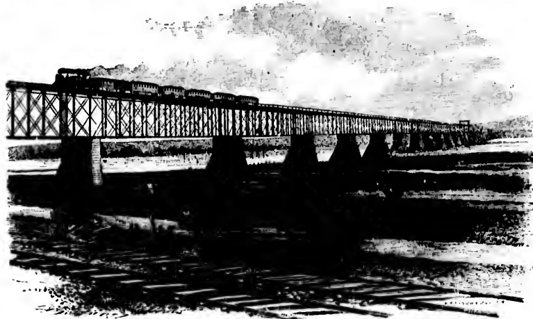
LA SALLE BRIDGE.
