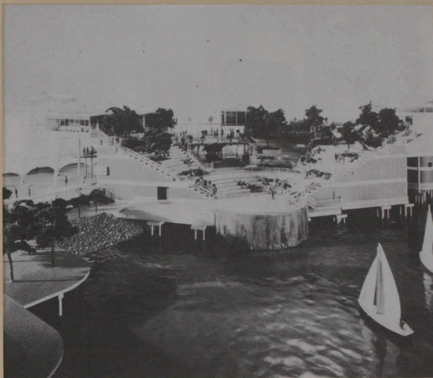
● Ci-dessus le pavillon de l'Ontario qui se trouve à l'entrée d'EXPO 86.
