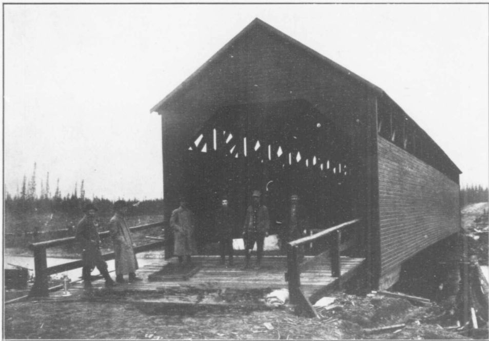
PREMIER PONT CONSTRUIT DANS L'ABITIBI.—Ce pont est situé sur le ruisseau " Peter Brown ", dans le 6ème rang du canton Figury.— Longueur 112 pieds.
