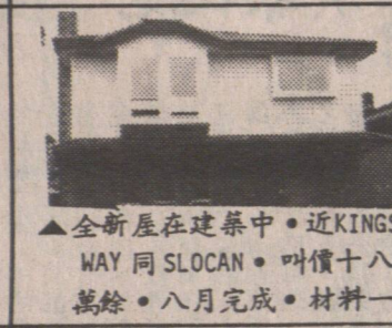
▲全新屋在建中, 近 KINGS WAY 同 SLOAN, 叫價十八 萬餘, 八月完成, 材料一流
