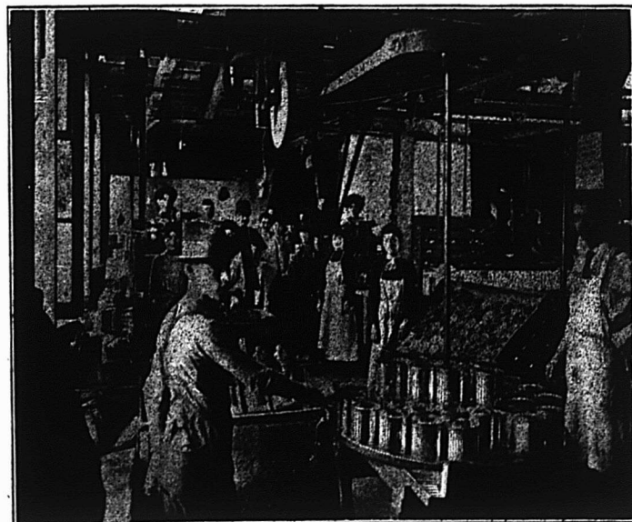
Fabrication des Boîtes à l'Etablissement de Wm. Clark, à Montréal.
