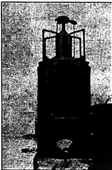
Le carbure ne s'évapore pas. Il est placé dans le gazogène en quantité suffisante pour donner la lumière pendant plusieurs jours, il est dans un récipient fermant hermétiquement et il peut y demeurer tant qu'il n'est pas dépensé. C'est là un fait important.
