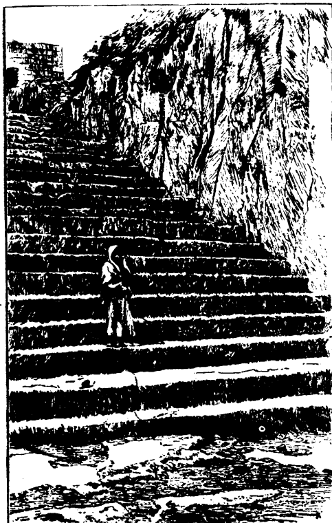
ESCALIER DU TOMBEAU DES ROIS A JÉRUSALEM
