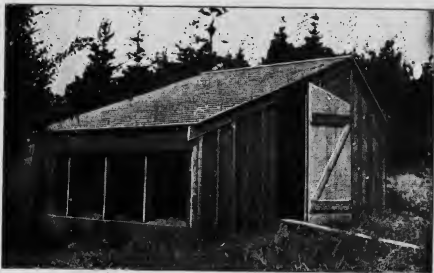
POULAILLER À DEVANT OUVERT EN COLOMBIE-BRITANNIQUE. Poulailler à devant ouvert, employé en Colombie Britannique. Ce poulailler donne aux volailles une abondance d'air pur et une certaine quantité de soleil. Il y a une fenêtre du côté opposé à la porte.
