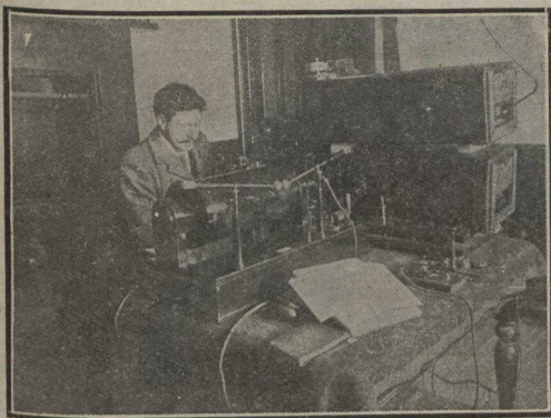
UN POSTE DE TELEGRAPHIE SANS FIL. — COMMENT ON EXPEDIE UN MESSAGE. — En appuyant sur un levier, l'expéditeur fait éclater, entre les deux boules de cuivre visibles sur notre gravure, des étincelles qui produisent des ondes électriques. Ces ondes, transmises par un câble au sommet d'un mât situé à l'extérieur du poste, s'irradient dans l'espace à la formidable vitesse de 300,000 kilomètres par seconde, et vont impressionner les appareils du poste récepteur et y transcrire le message.
