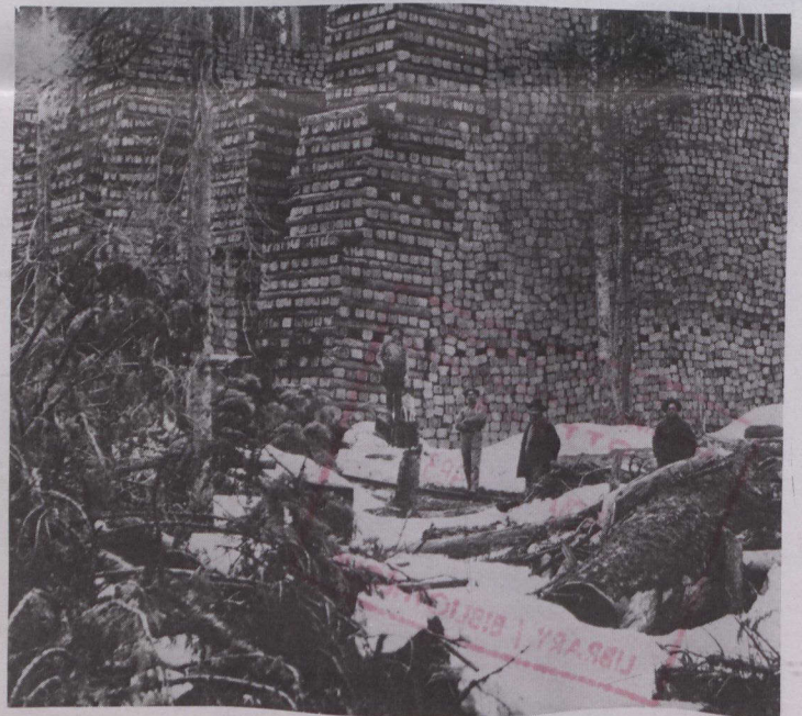
Construcción se utilizaron 2.000 de traviesas de pino de la C.B.
