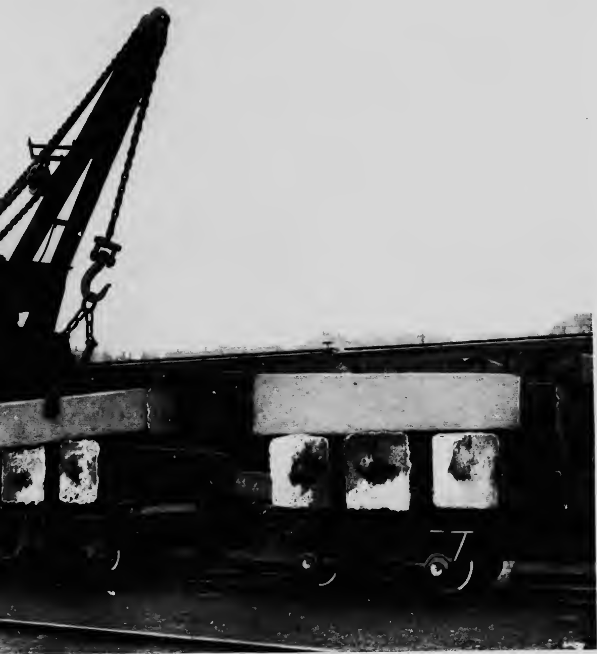
LINGOTS DE 3 TONNES POUR LES LAMINOIRS
