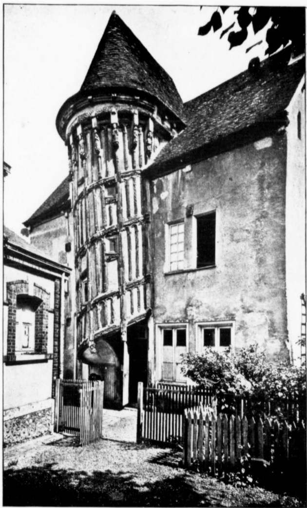
FIG. 18 —Escalier de la reine Berthe Chartres
