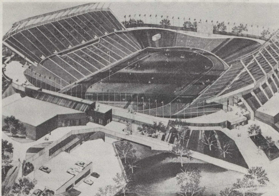
Le stade du Commonwealth a une piste artificielle de 400 m. Toutes les épreuves se feront sur une pelouse d'herbe naturelle. Le stade de 42 000 sièges peut accueillir jusqu'à 52 000 personnes.
