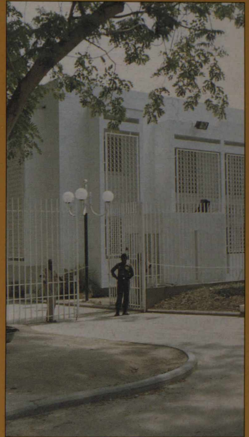
◀ La nouvelle chancellerie qui abrite les bureaux de l'ambassade du Canada à Kinshasa (Zaïre)
