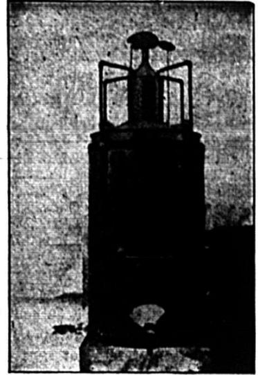
Le carbure ne s'évapore pas. Il est placé dans le gazogène en quantité suffisante pour donner la lumière pendant plusieurs jours, il est dans un récipient fermant hermétiquement et il peut y demeurer tant qu'il n'est pas dépensé. C'est là un fait important.
