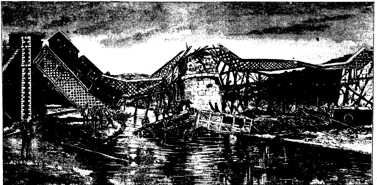
ESPAGNE — La catastrophe du pont d'Alcudia, sur la ligne de Ciudad Real.
