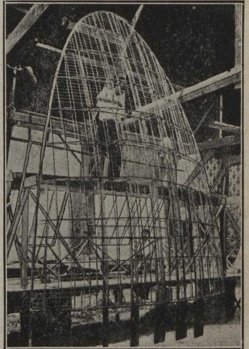
**Construction de la charpente d'une aile de monoplane.**
