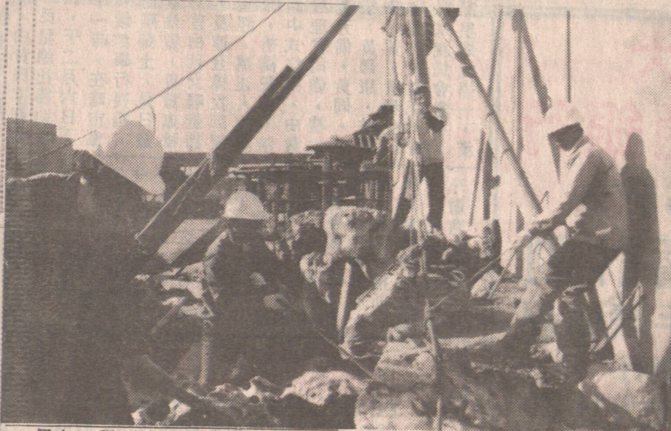
△假山工程正在進行中。
