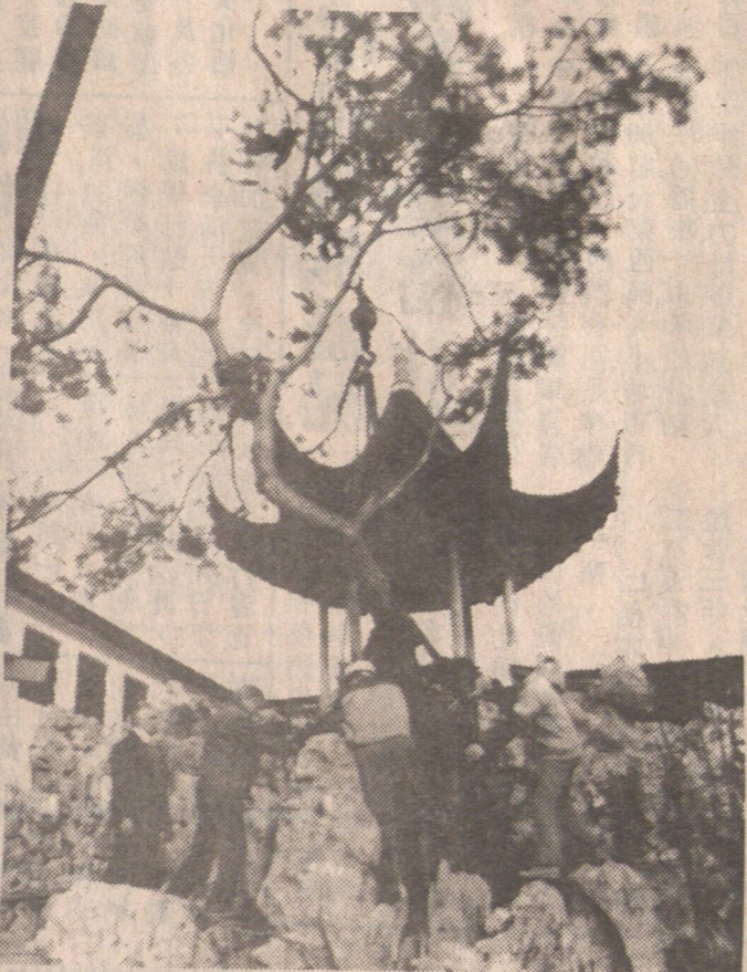
△綠化工程正在進行中。
