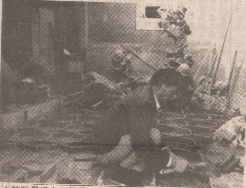
△技師們正在砌築花街。
