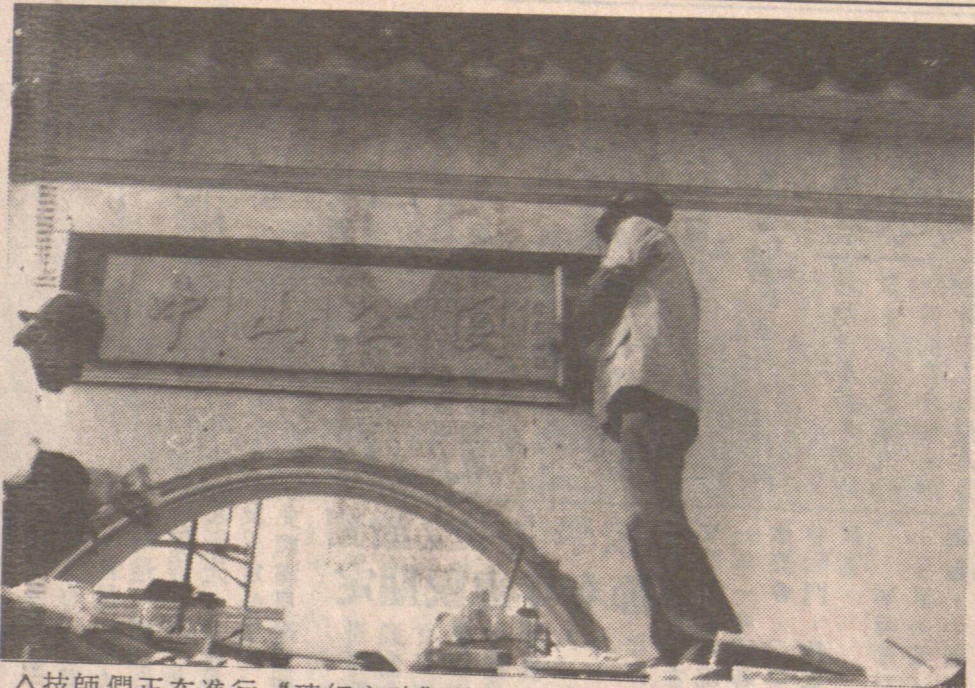
△技師們正在進行「磚細字碑」的按裝施工。
