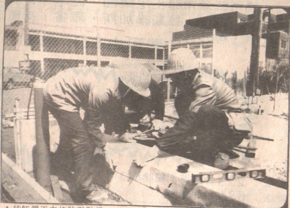
△技師們正在按裝石階沿。
