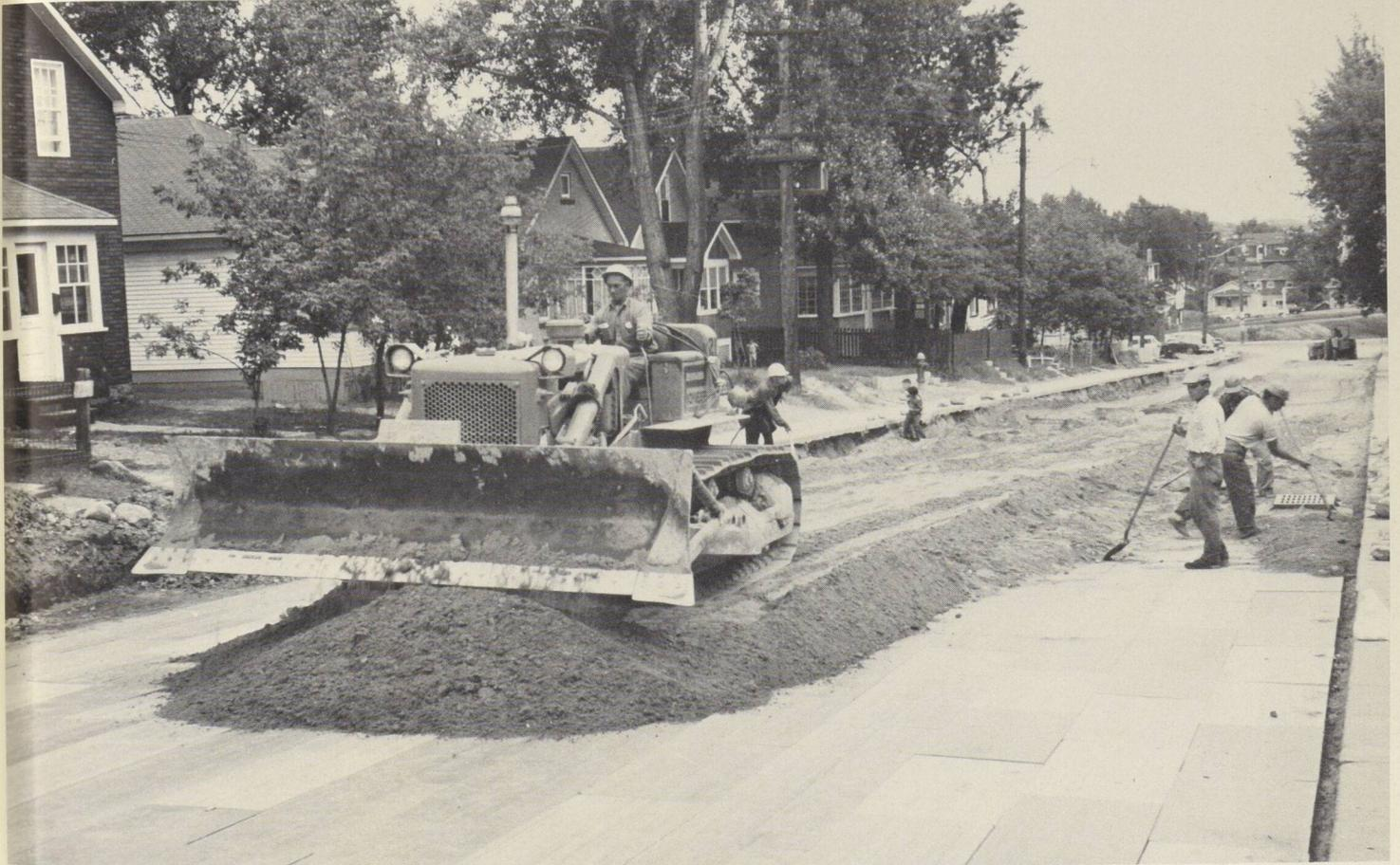
plus grande partie de l'hiver. Il peut se faire que des boursofflements se produisent encore mais que la déformation de la surface de la route, du fait des lentilles de glace dans les sous-couches, soit modérée. Ainsi, la couche de gravier sera suffisamment forte pour ne pas céder sous les charges des véhicules lourds même s'il y a ramollissement des sous-couches en-dessous du gravier au moment du dégel.
