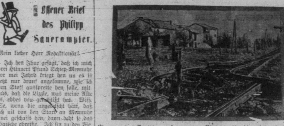
Eine von den Deutschen angenommene Photographie, die zeigt, wie die Italiener auf ihrem Rückzuge die Eisenbahngleise zerstörten.
