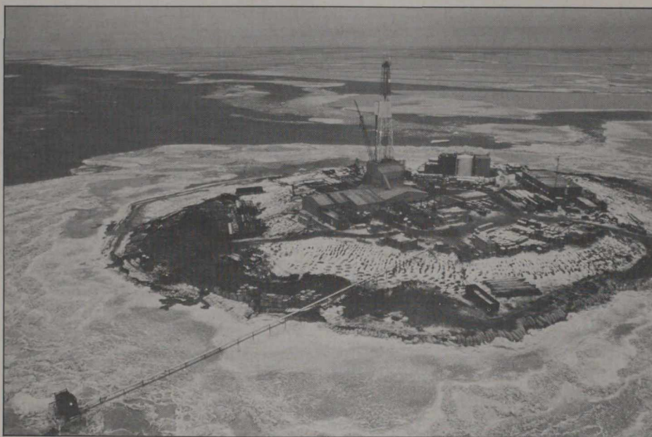
Dans la mer de Beaufort (océan Arctique). Une île artificielle construite pour la recherche des hydrocarbures.
