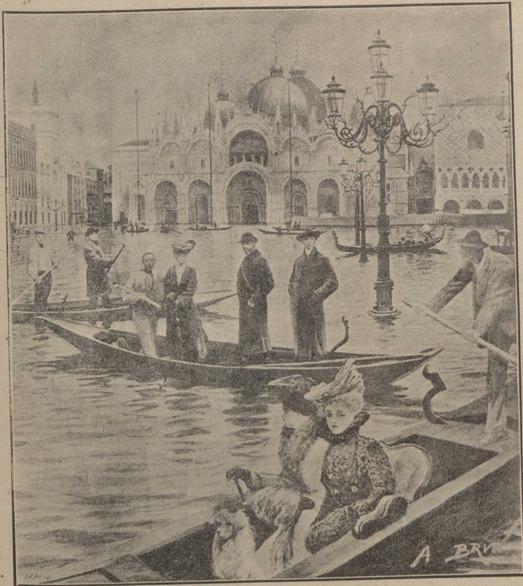
LES INONDATIONS DE VENISE — La place Saint-Marc envahie par les eaux.
