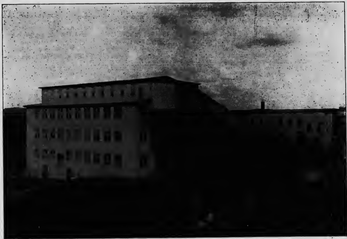
(Fig. 15.)—Un atelier de préparation de l'amiante à Black Lake.
