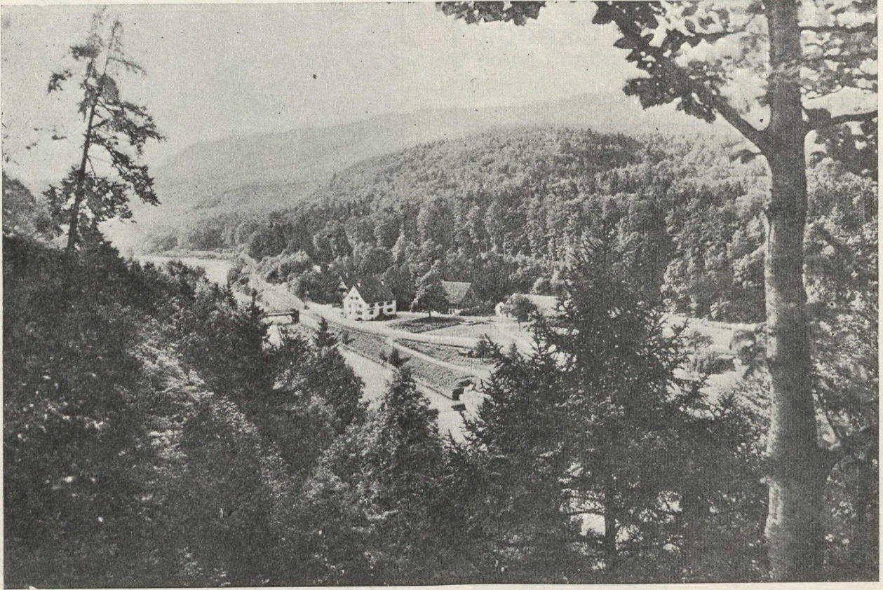
Vue d'une partie du territoire forestier bien organisé de la Suisse, montrant la résidence de l'inspecteur-forestier du district
