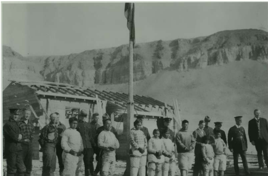
Fig. 26 Bache Peninsula post under construction, 1926 Le poste de police en construction, presqu'île Bache, 1926 LAC/ BAC, e010752413
