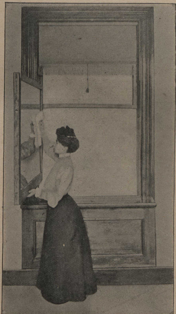
Photographie montrant la facilité de transformer le châssis guillotine
