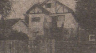
2241 E 12街樓上四睡房 土庫完成, 地大
