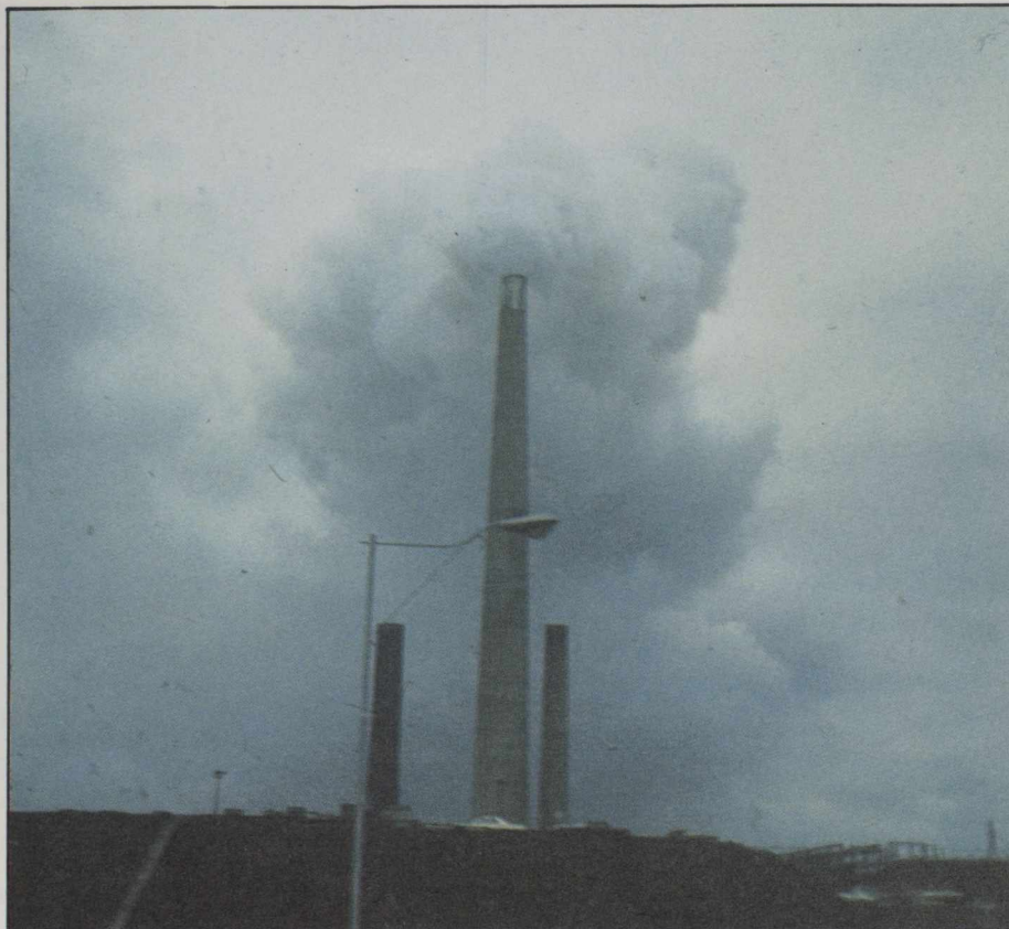
La cheminée géante de l'INCO Limited, située à Copper Cliff en Ontario est devenue le symbole des pluies acides et du transport des polluants sur de grandes distances.
