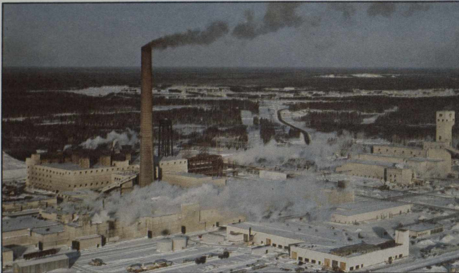
La fonderie de nickel de l'INCO Limited à Thompson (Manitoba) qui émet 359 000 tonnes métriques de SO 2 par année n'a pas installé de dispositif de confinement de l'anhydrique sulfureux.
