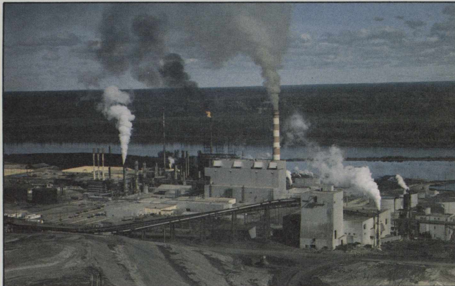
L'usine de pétrole synthétique Suncor, à Fort McMurray, est la plus importante source d'émissions d'anhydride sulfureux en Alberta, celles-ci étant annuellement de l'ordre de 93 000 tonnes.
