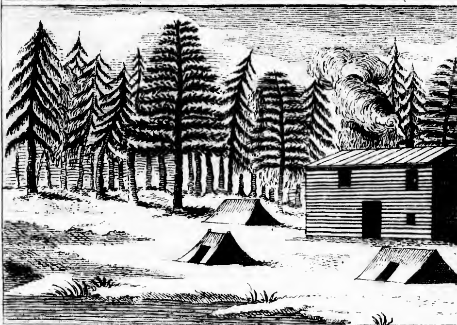
Vue de la Maison de Montagne du côté de la
