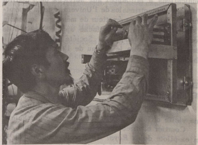
Willie Adams, résident de Rankin Inlet, règle le dispositif de conférence du Comminterphone dans le central téléphonique d'une petite communauté septentrionale.
