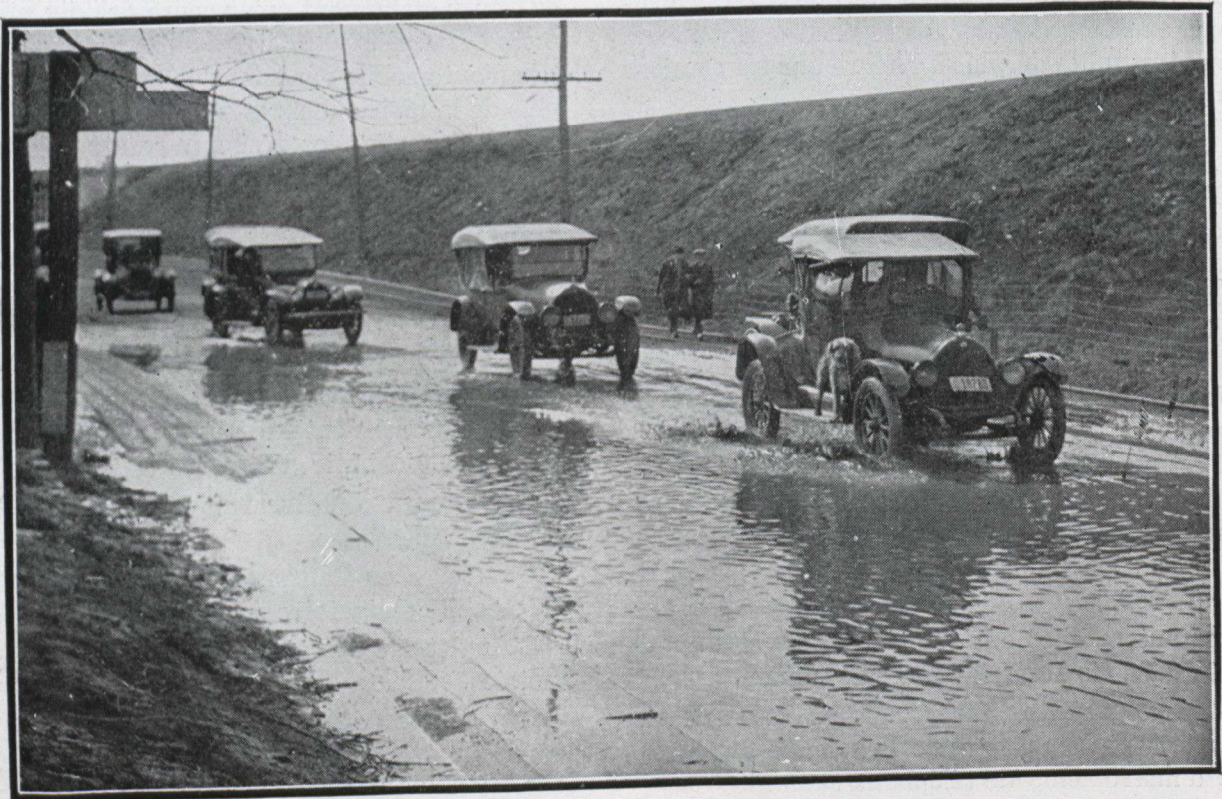
NOS BONNES ROUTES : Conditions adverses qui font subir de dures épreuves à nos routes. Cette vignette représente une rue inondée soumise à une circulation considérable.
