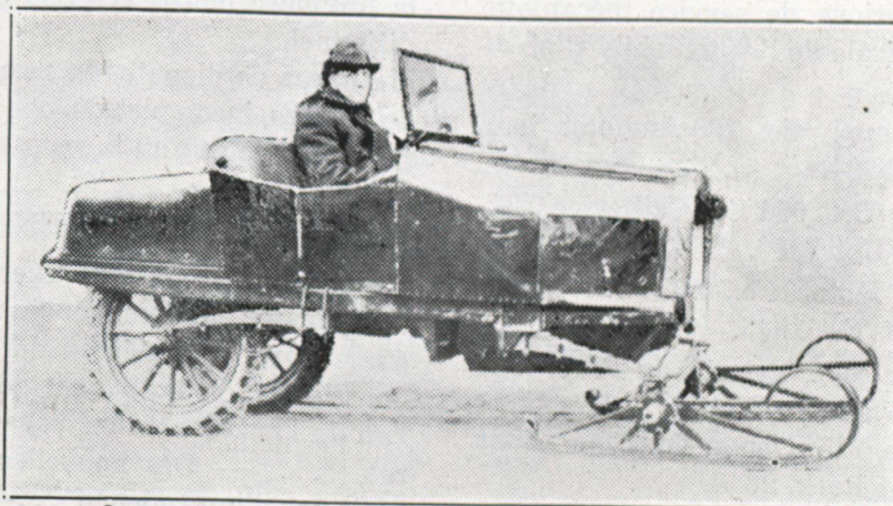
AUTOMOBILE D'HIVER, dont le train avant est installé sur des patins. Ce type a été créé par M. Ferdinand Roux, distributeur de la Chevrolet à Ste-Thérèse. Ce type est une reproduction exacte mais en raccourci du modèle 490 de la Chevrolet, et il n'y a pas de chemins de campagne, de tempête, de bancs de neige pour enrayer sa marche. Il peut faire de 30 à 35 milles à l'heure. (Vig. "La Patrie", Montréal.)
