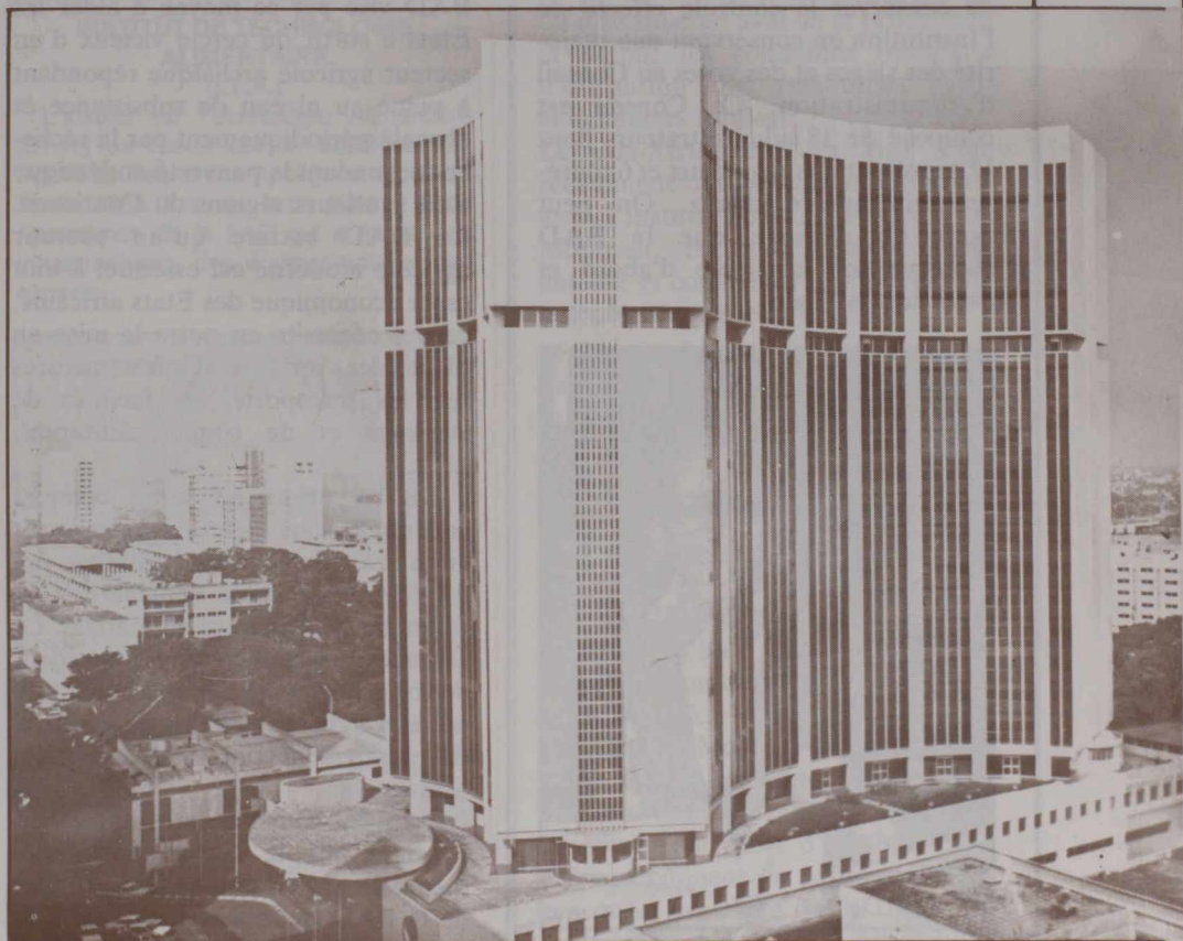
● Le siège social de la BAD à Abidjan
