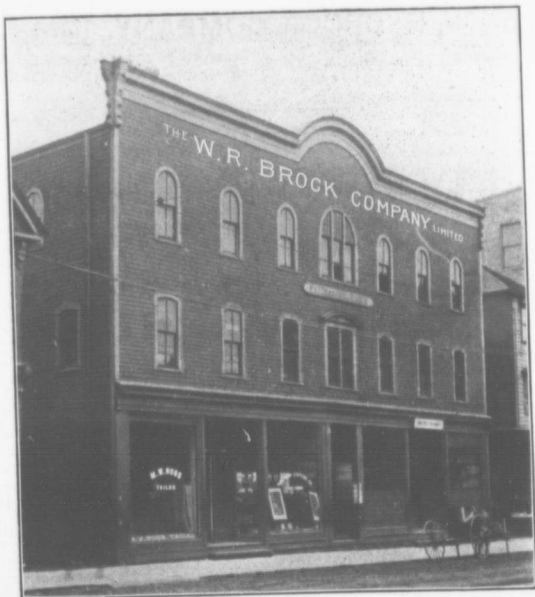
Salle d'Echantillons de THE W. R. BROCK CO. (Limited), MacDonald Bldg., Sydney, Cap Breton.
