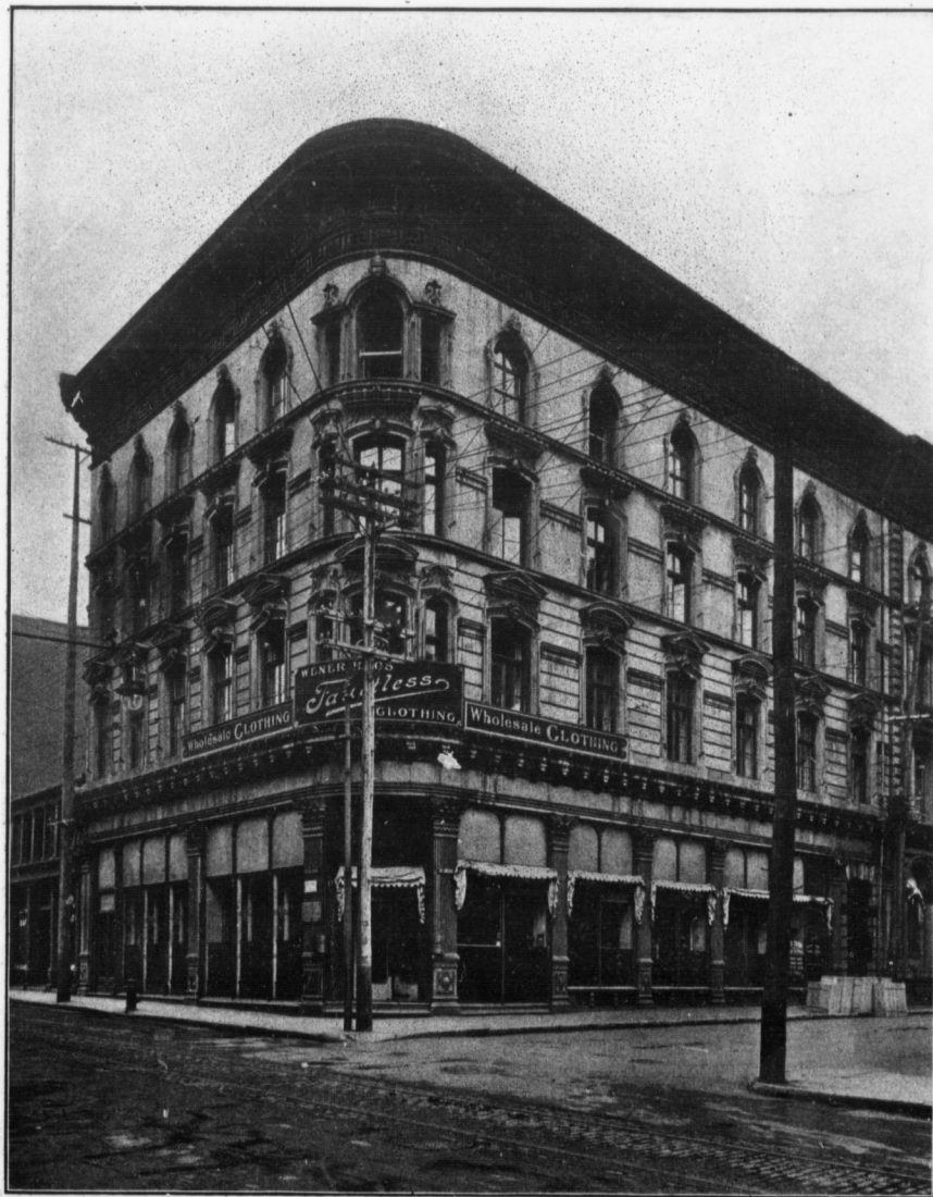
Magasins et Entrepôts à l'angle des rues Notre-Dame et Ste-Hélène, MONTREAL.
