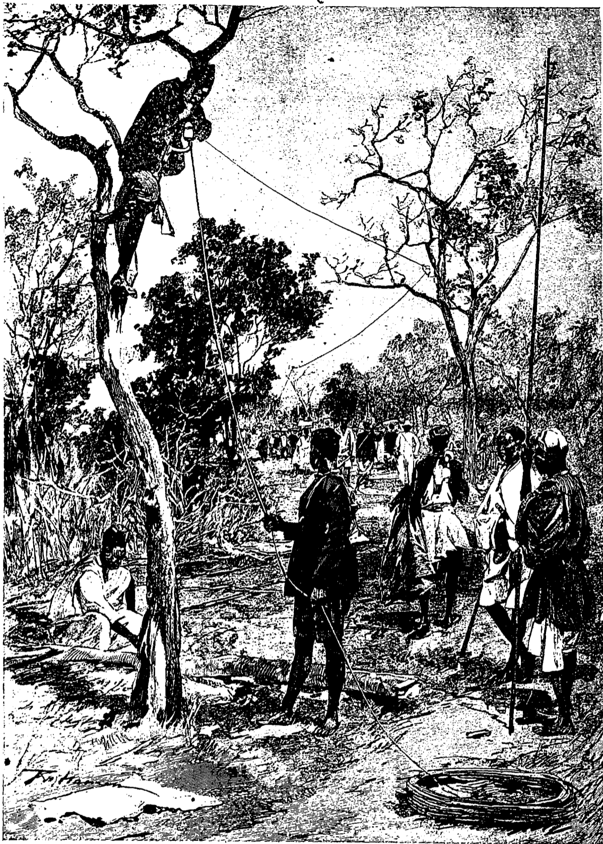
POSE D'UNE LIGNE TÉLÉGRAPHIQUE DANS LE SOUDAN FRANÇAIS.
