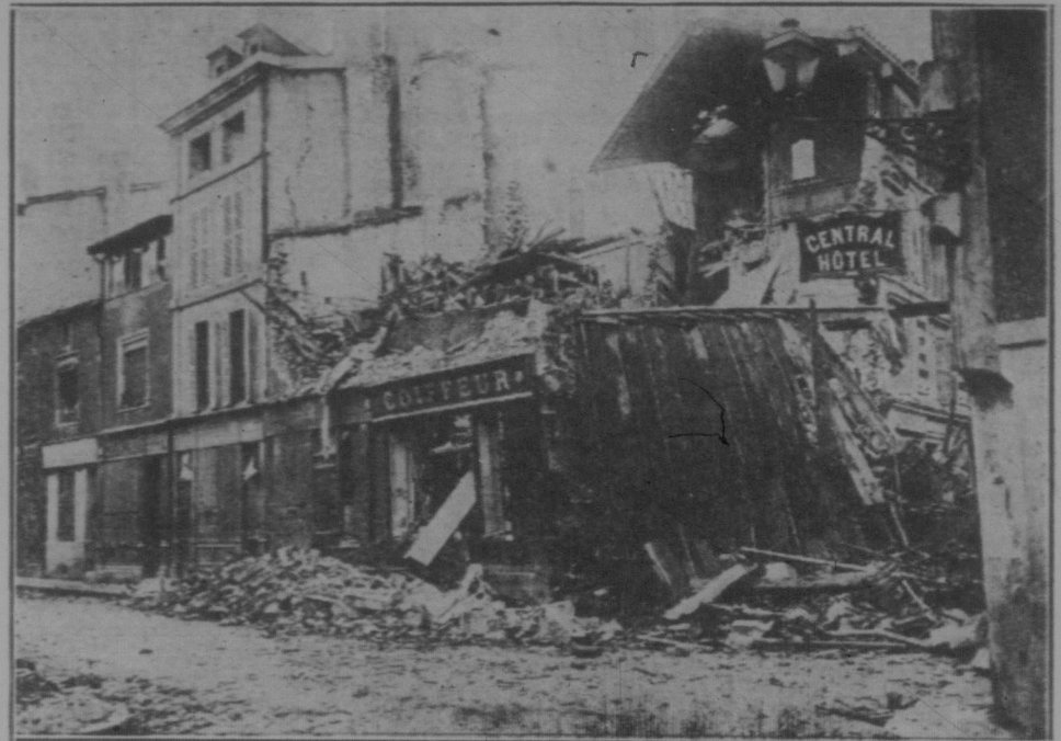
Das Central Hotel in der Nähe von Verdun, das teilweise von den Granaten zerstört wurde.
