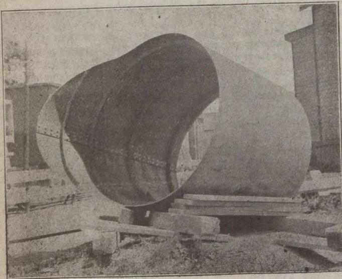
FIG. 2—TUNNEL DRUM USED FOR 5-FT. CIRCULAR BLOCK SEWER
