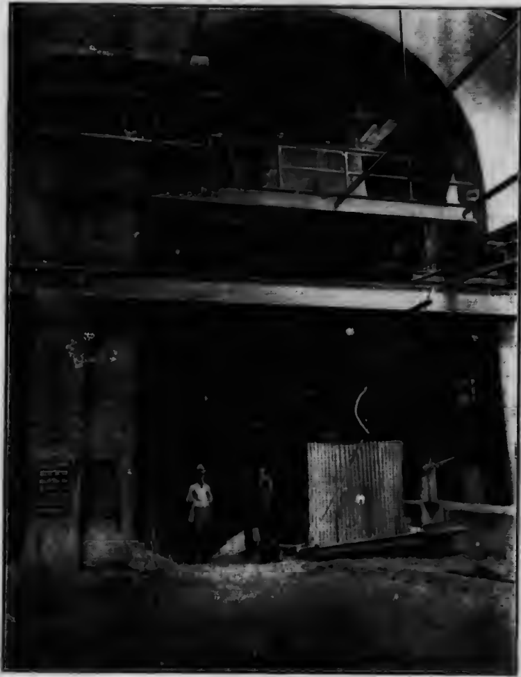
Vue générale du four Elektrometall.
