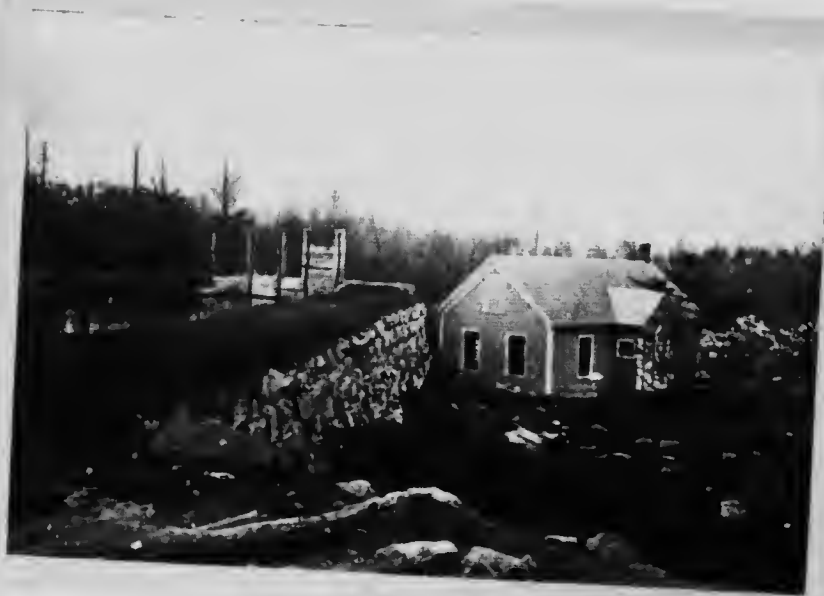
USINE HYDRO-ELECTRIQUE MUNICIPALE DE SHELBURNE SUR LA RIVIERE MEDWAY. NOUVELLE FOSSE
