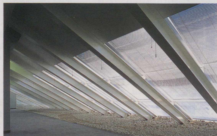
外光をいっぱい採り入れた7階の廊下。
