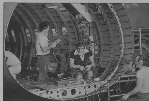
Montage Aéronautique — Canadair — Montréal Photo : Centre ASC
