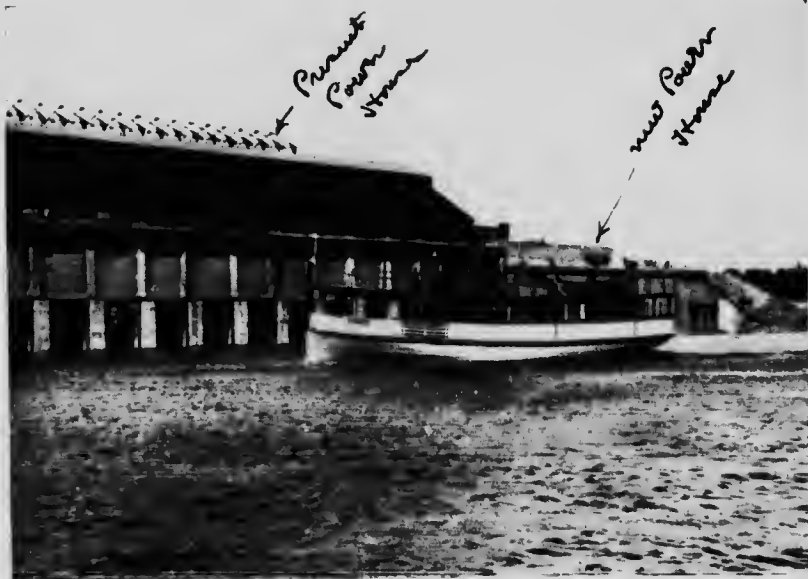
ANCIENNE ET NOUVELLE USINES GÉNÉRATRICES DE LA ST. LAWRENCE RIVER POWER COMPANY, (ALUMINIUM Co.), MASSENA, N.Y.
