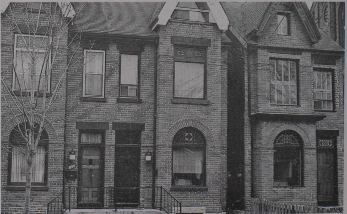
Restauracion de un barrio de la zona antigua de Toronto.
