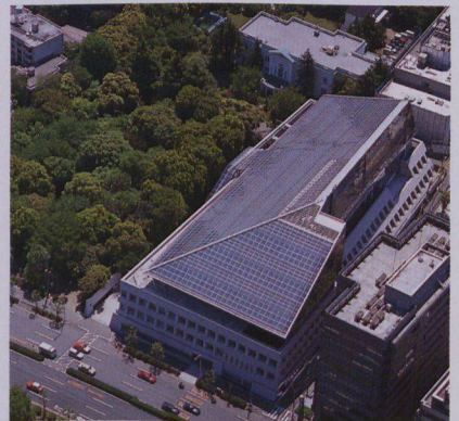
(Photo: Shimizu Corporation) (Photo: Shimizu Corporation) (写真提供：清水建設株式会社)
