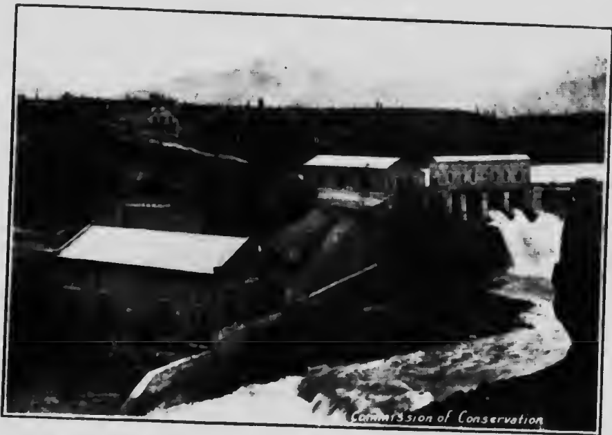
RIVIERE BOW USINE HYDRO ELECTRIQUE A LA CHUTE FER A CHEVAL
